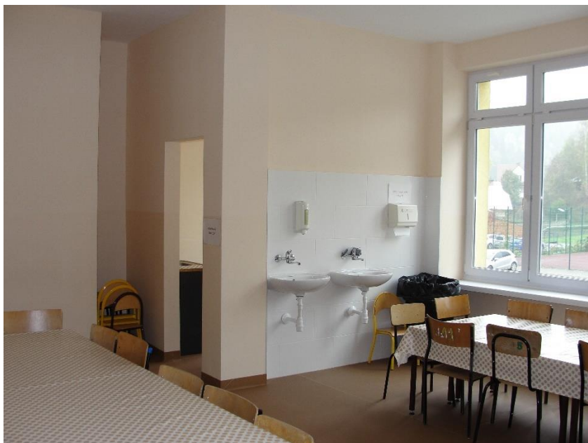
Szkoła Podstawowa Nr 3. Remont jadalni. Zadanie w trakcie realizacji. Fot MCOiUW 2025
