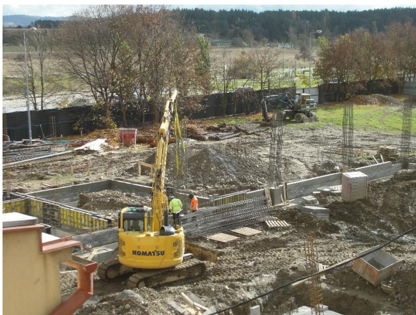
Szkoła Podstawowa Nr 11. Budowa nowej sali gimnastycznej Fot MCOiUW 2025
