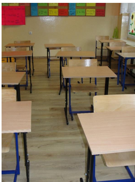
Szkoła Podstawowa Nr 5. Sala lekcyjna po wymianie podłogi. Fot MCOiUW 2025
