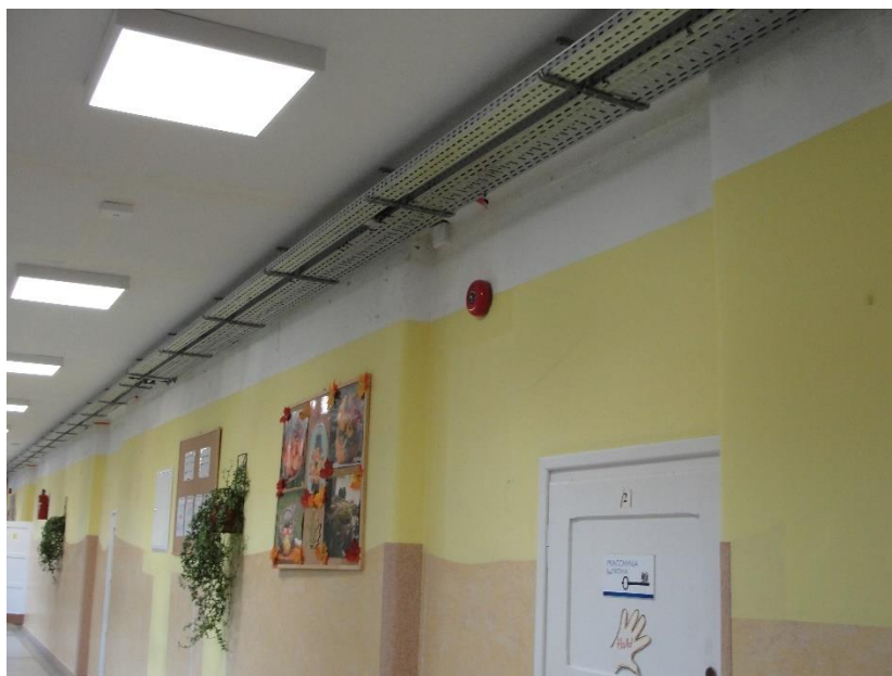
Szkoła Podstawowa Nr 2. Wymiana instalacji elektrycznej. Zadanie w trakcie realizacji. Fot MCOiUW 2025
